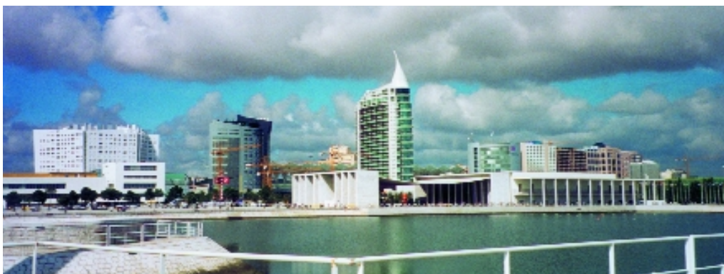
Le site de l'Expo'98 à Lisbonne, très dégradé à l'origine, a été métamorphosé.
