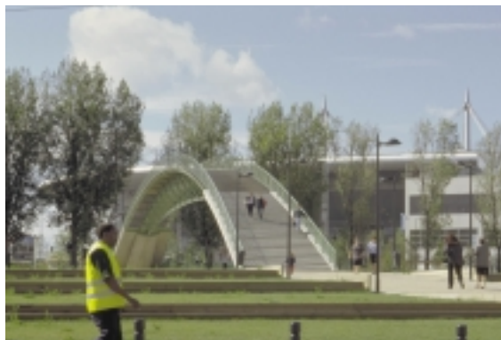
Face au Stade (2nd plan), une passerelle sur le canal crée une liaison avec les quartiers voisins.
