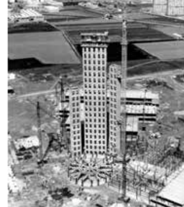
1969-1971 Construcció de l'Hospital de Bellvitge Construcción del Hospital de Bellvitge Construction of Bellvitge Hospital
