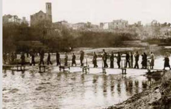
Passera del riu Llobregat a Sant Boi Pasarela del río Llobregat en Sant Boi Walkway over the River Llobregat at Sant Boi
