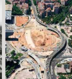
2014 L'enderroc / El derribo / The demolition Plaça de les Glòries
