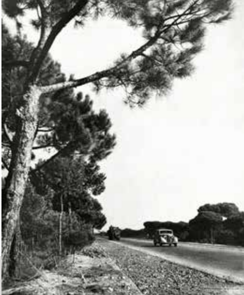
1. 1954 Autovia de Castelldefels
