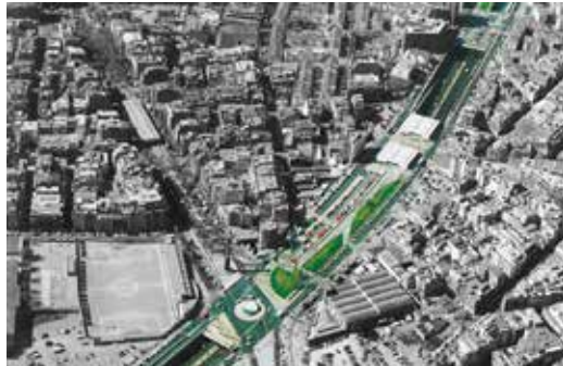
5. 1992 Cobriment i equipaments sobre la Ronda de Dalt entre Roquetes i Verdum
