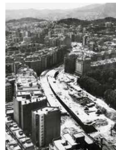
5. 1973 Construcció del viaducte d'Alfons X a la Ronda del Guinardó
