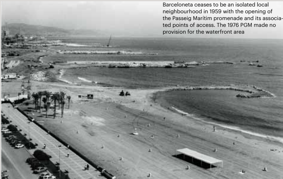
1988 Vista general de la construcció del Port Olímpic i dels espigons de Bogatell i Bac de Roda Vista general de la construcción del Puerto Olímpico y de los espigones de Bogatell y Bac de Roda View of construction of the Olympic Port and groynes at Bogatell and Bac de Roda
