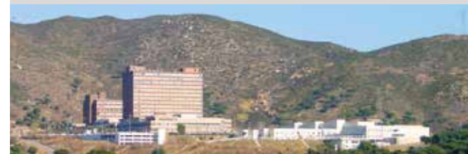
1973-1979 Construcció de l'Hospital Germans Trias i Pujol, Can Ruti, Badalona. Construcción del Hospital Germans Trias i Pujol, Can Ruti, Badalona. Fotografia de 2005 Construction of Hospital Germans Trias i Pujol, Can Ruti, Badalona. Photograph from 2005
