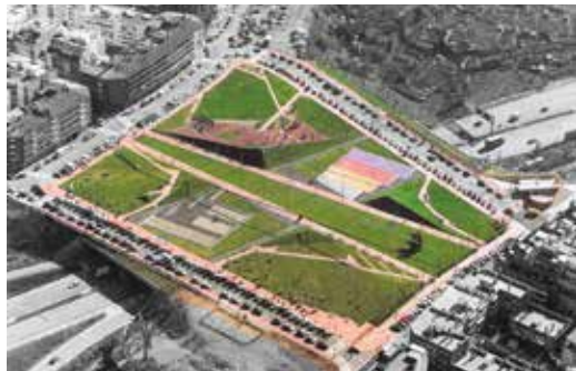
3. 1995 Parc de la Solidaritat sobre la Ronda de Dalt a L'Hospitalet de Llobregat
