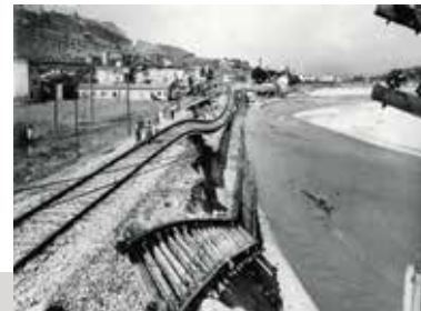
2. 1962 Inundacions. Destrosses a les vies del ferrocarril al meandre del Besòs, entre Sant Andreu i Montcada
