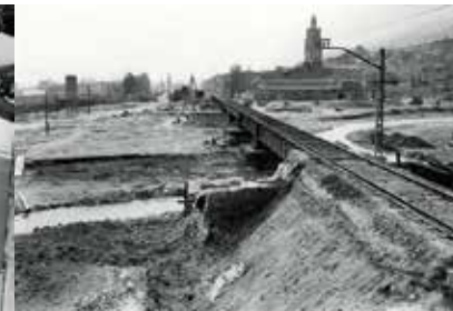
3. Reparació provisional del pont sobre el riu Ripoll
