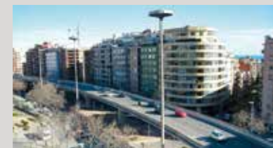
6. 2005 Enderroc de la meitat del viaducte d'Alfons X
